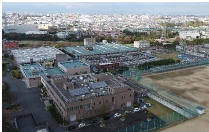
泉北水再生センター
