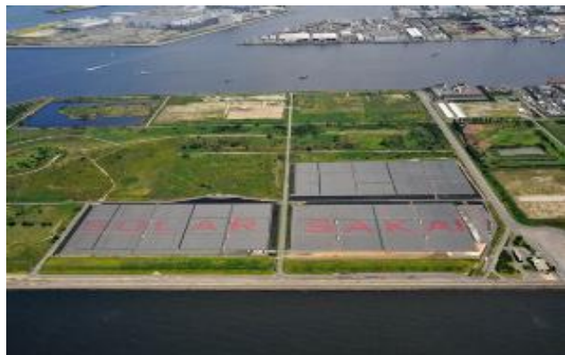
関西電力（株）堺太陽光発電所
