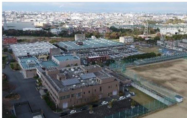
泉北水再生センター
