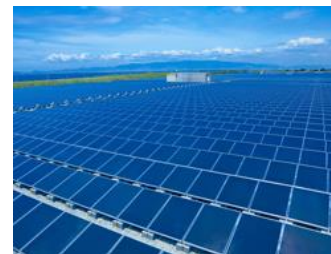
関西電力（株）堺太陽光発電所
