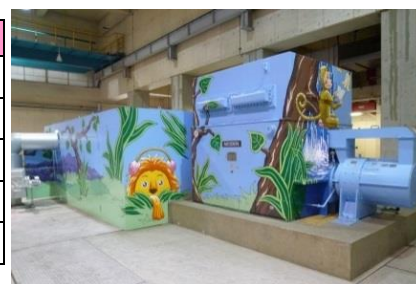
東工場第二工場発電設備
