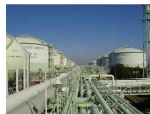
大阪ガス（株）泉北製造所
