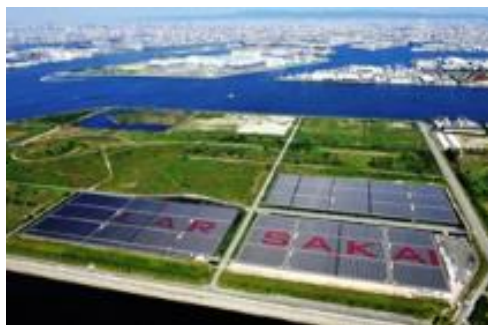
関西電力（株）堺太陽光発電所
