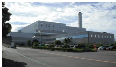
《東工場第二工場》
