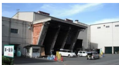
《東工場第一破碎施設》
