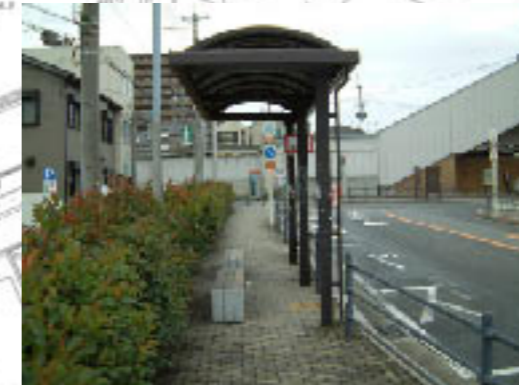
○路線図・料金表等の設置・改良 ○点字・音声誘導設備の設置・改良 ○ベンチ等の設置
