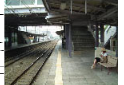
No.6 プラットホーム
