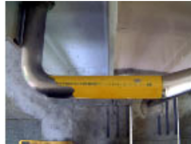
No.2 階段手すり
