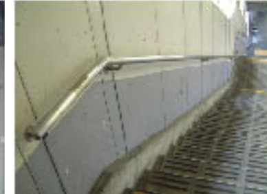
No.9 階段の手すり
