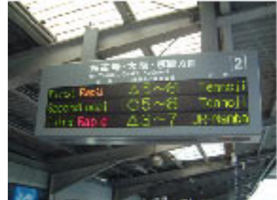
No.13 プラットホーム上の電光表示
