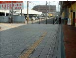
警告ブロック
