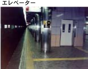
エレベーター
