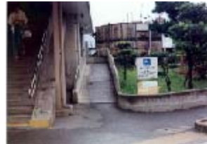
車いす専用スロープ
