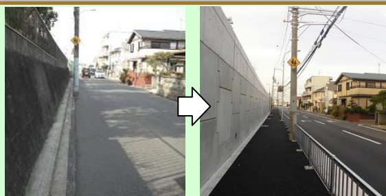
＜整備前＞⇒＜整備後＞ 安全な歩行空間の整備（歩道整備）
