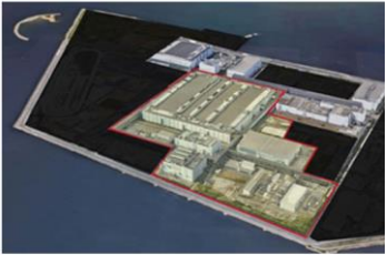
シャープ堺工場内のデータセンター設置予定エリア（赤枠）
