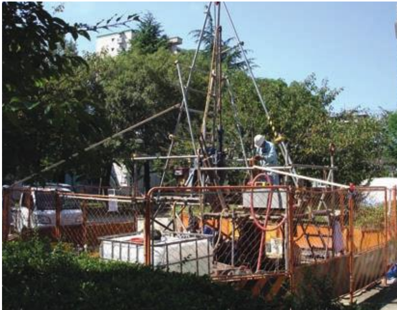
ボーリング掘削
