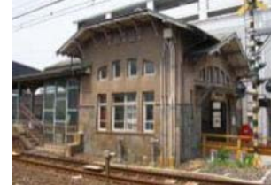
現在の諏訪ノ森駅舎
