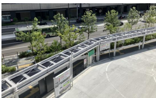
例：小規模な屋根を活用した次世代太陽電池の設置 (うめきたグリーンプレイス 駅前広場)
