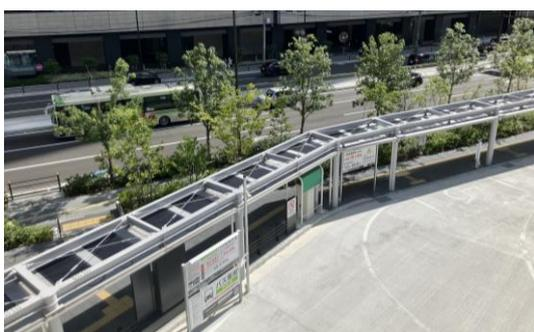
例：小規模な屋根を活用した次世代太陽電池の設置
