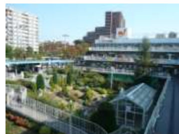
榎・美木多駅周辺の商業施設
