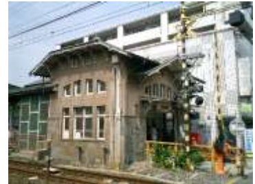
2 諏訪ノ森駅(昭和 8 年建築)
