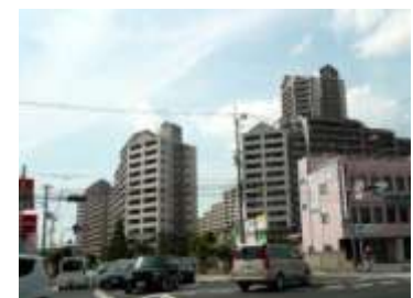
4 高層マンションが建ち並ぶ景観
