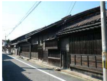
3 伝統的な町家によるまちなみ
