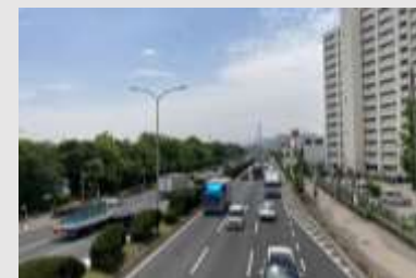
⑤大阪中央環状線
