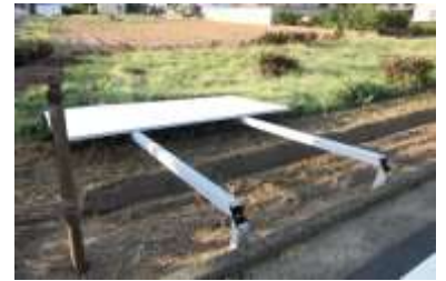
屋外広告物の倒壊
