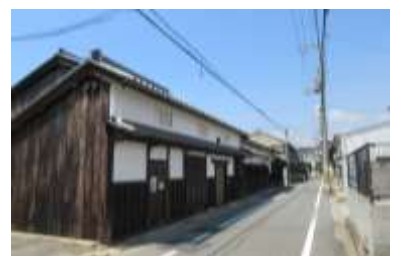
現存する伝統的な町家
