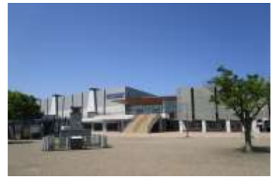
大浜体育館・大浜武道館
