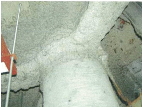
鉄骨耐火被覆
