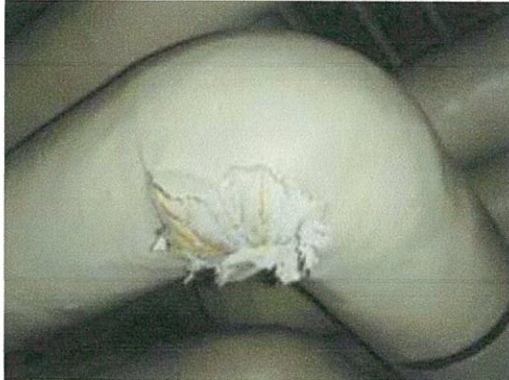
配管エルボの保温材
