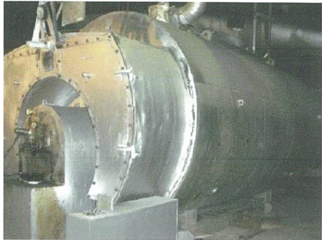
ボイラーの保温材
