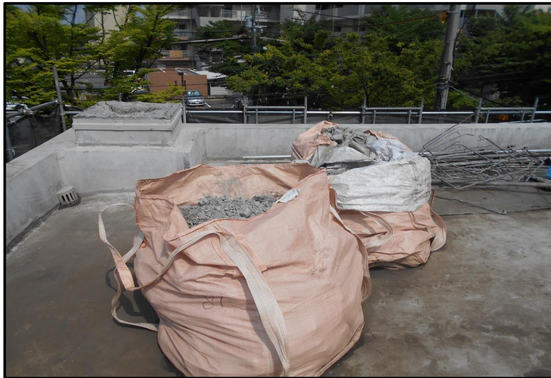
6/20(月)機械室棟屋上の煙突と解体材の状況
