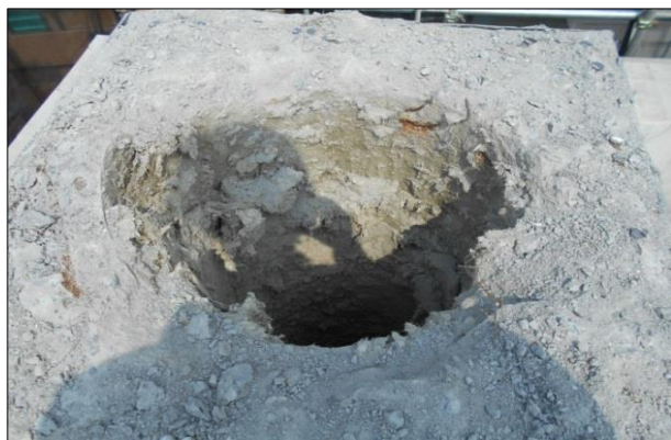
㊨(事故後)煙突解体後の状況(屋上)
