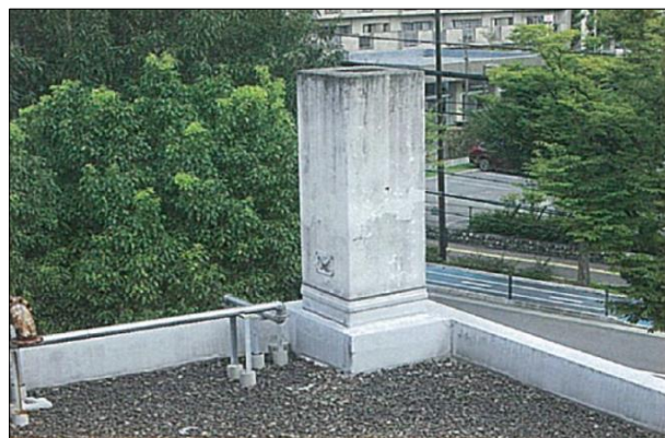
㊧(工事着手前)機械室棟煙突
