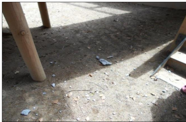
㊩(事故後)隣接保育園園庭のガラ落下状況
