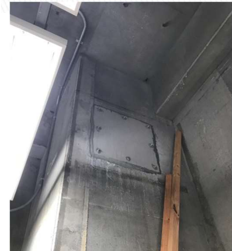
室内煙突上部開口部封鎖状況
