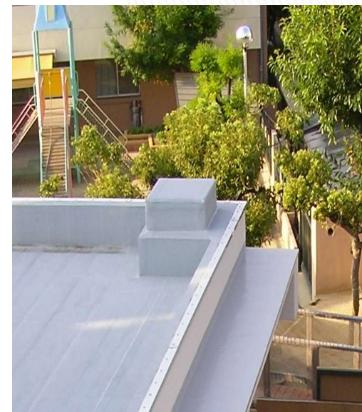
屋外煙突上部開口部封鎖状況
