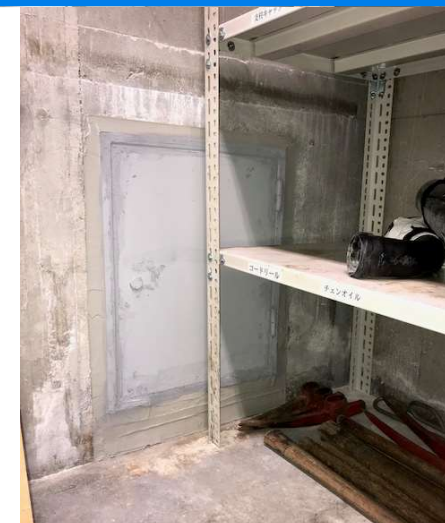
室内煙突下部開口部封鎖状況
