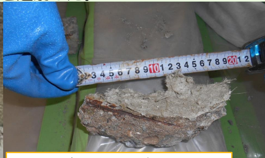
断熱材が付着したガラの試験体 (幅約20cm)
