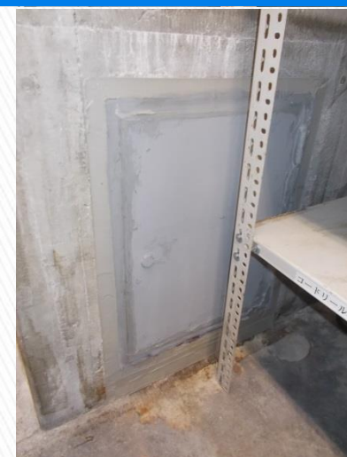
室内煙突下部開口部封鎖状況
