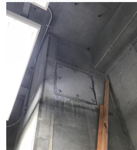
室内煙突上部開口部封鎖状況
