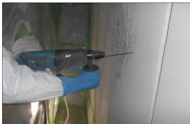
○電動ドリルによる剥離作業
