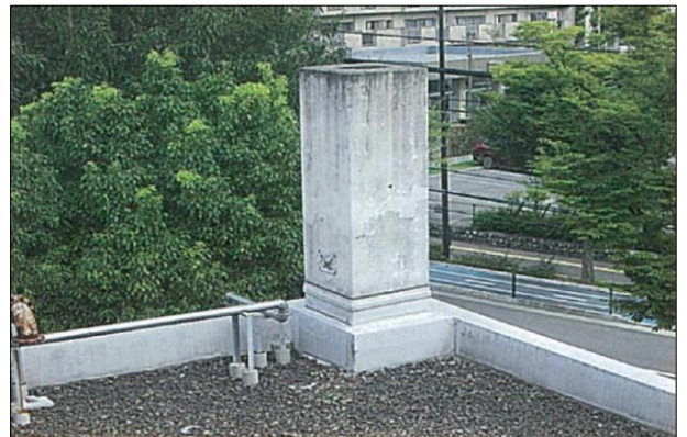
①(工事着手前)機械室棟煙突
