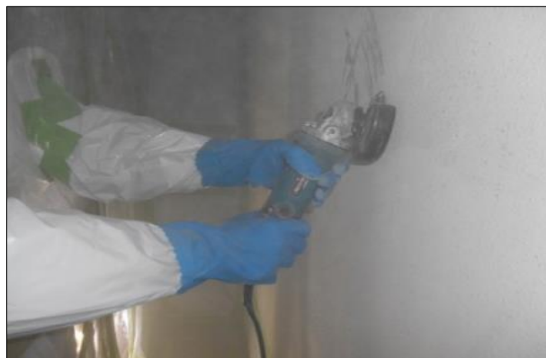
○電動カッターによる剥離作業
