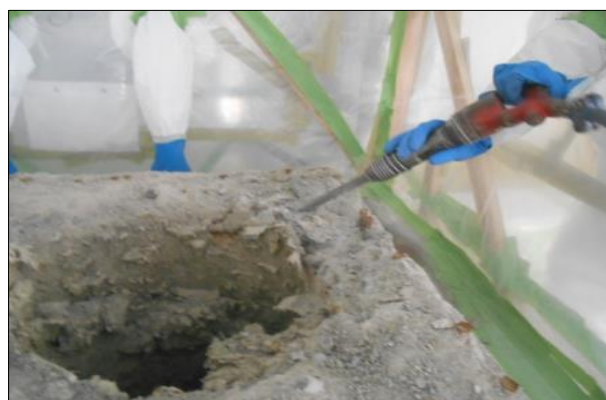
(断熱材のはつり)
