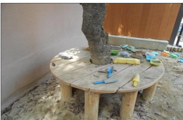
⑤(事故後)隣接保育園園庭のガラ落下状況
