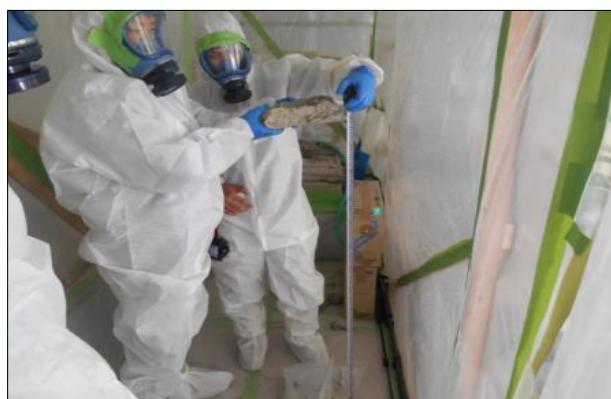
○はつりガラの落下検査状況 (落下高さ確認)
