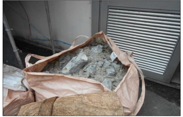
㊧ (事故後) 煙突解体後のガラ集積状況 (屋上)
