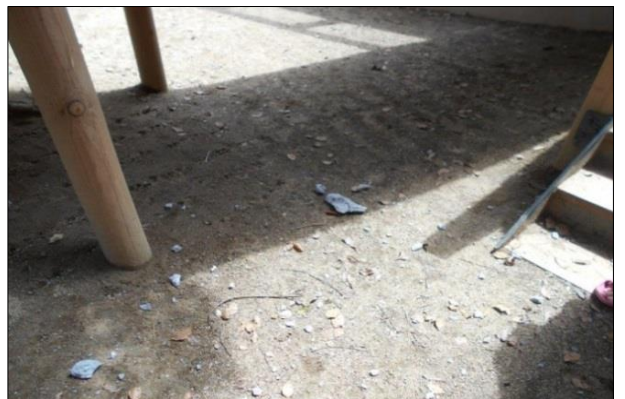
⑥(事故後)隣接保育園園庭のガラ落下状況
