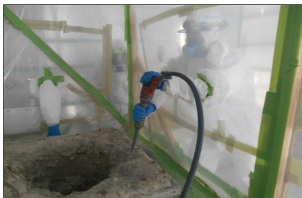
○煙突のはつり作業状況 (上部を外から内へはつり)
