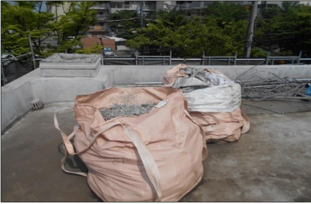
㊦ (事故後) 煙突解体後のガラ集積状況 (屋上)
