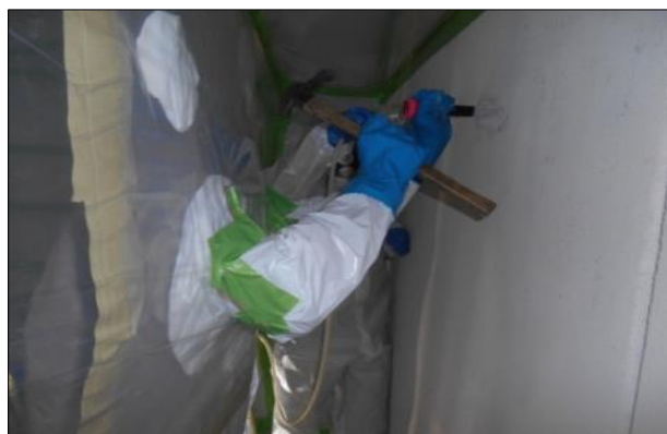
○タガネとハンマーによる剥離作業
