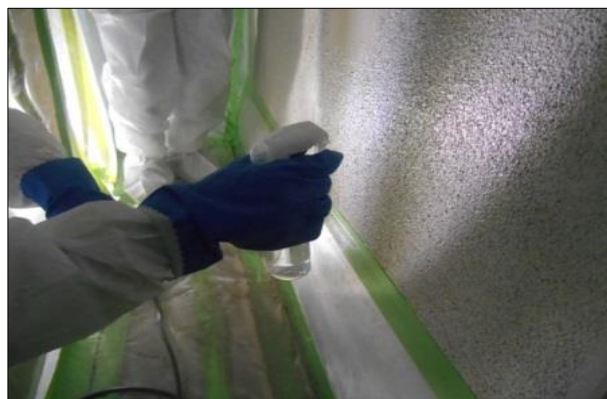
○壁面の湿潤作業
