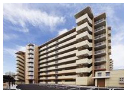
市営住宅(建替住宅)
