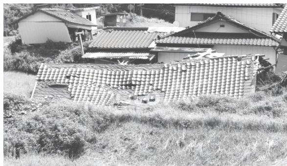
■地震による被災住宅
