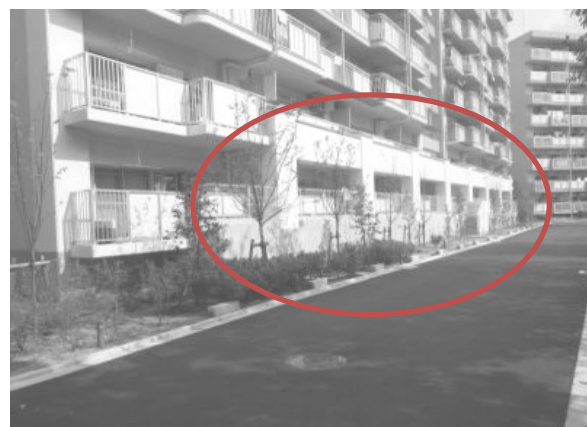
■公営住宅の耐震改修
