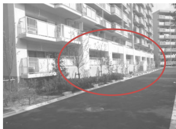
■公営住宅の耐震改修
