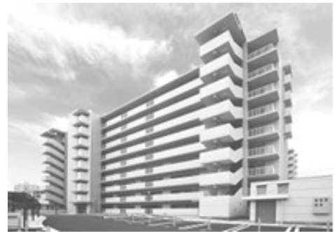
■市営住宅(建替住宅)
