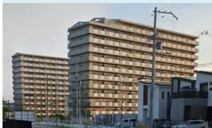
市営深井中町住宅（中区）
