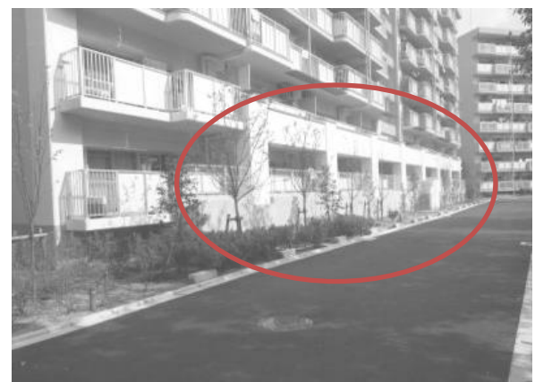
■公営住宅の耐震改修
