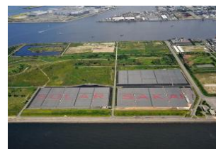
関西電力（株）堺太陽光発電所
