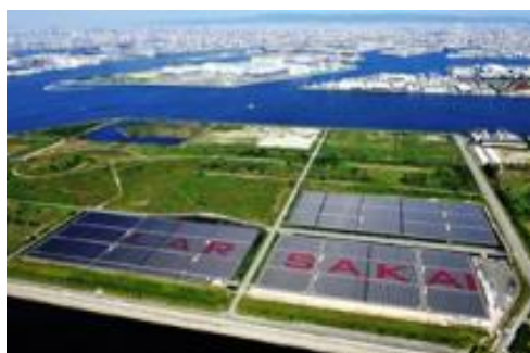
関西電力(株)堺太陽光発電所
