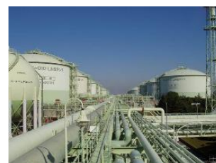
大阪ガス（株）泉北製造所
