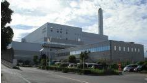
東工場第二工場
