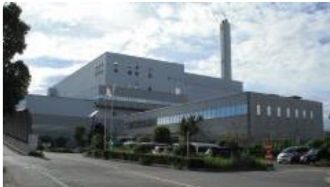
東工場第二工場
