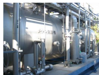
《メタン発酵施設》
