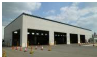
図9 東工場貯留施設
