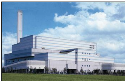
クリーンセンター東工場第二工場
