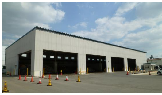
クリーンセンター東工場貯留施設
