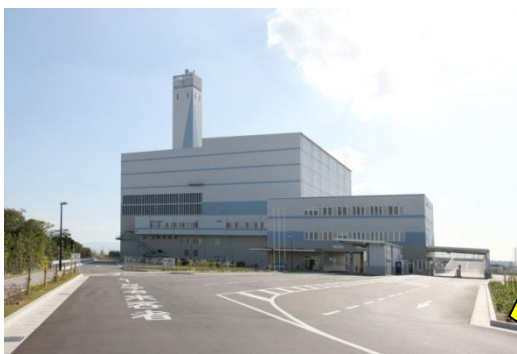
クリーンセンター臨海工場
