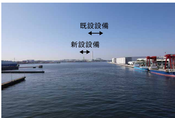
③南港大橋
