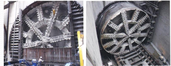
シールド工事の事例
