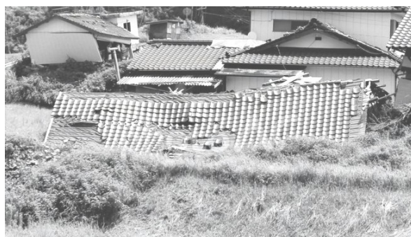
■地震による被災住宅
