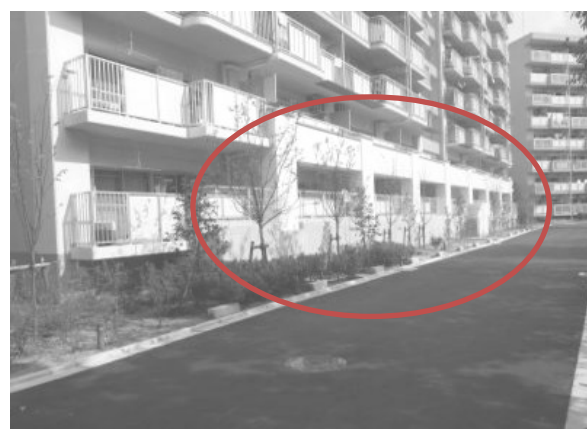
■公営住宅の耐震改修
