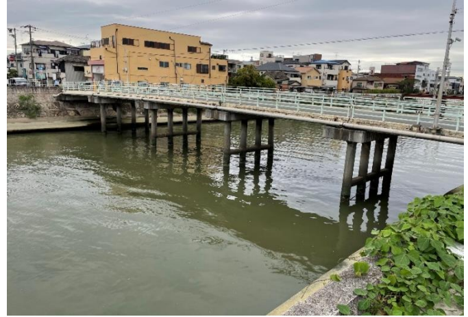
本市で同様の橋脚を有する橋（太陽橋）
