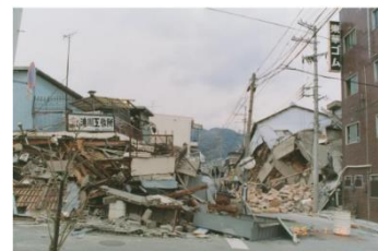
建物倒壊による道路閉鎖（神戸市）
