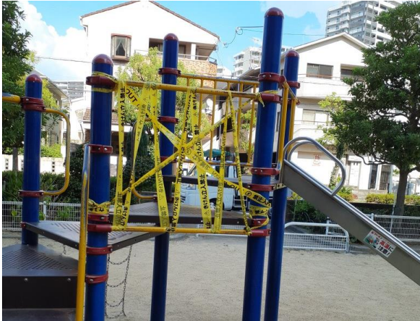
複合遊具の一部の腐食
