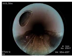
テレビカメラ調査による管きょの劣化状況
