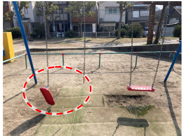
踏み板式ぶらんこの吊具の劣化
