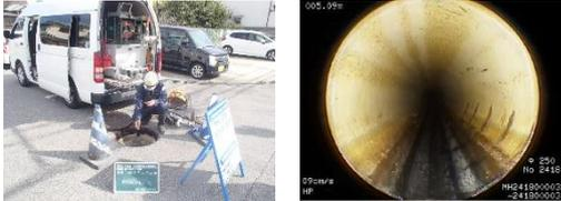
テレビカメラ調査による管きよの劣化状況
