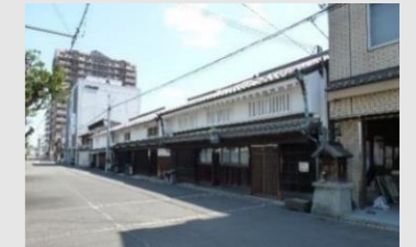
⑪ 古くからの町家が残る大道筋沿いのまちなみ
