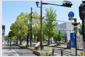
⑤国道26号（フェニックス通り）
