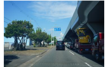
泉大津美原線（松原泉大津線） ・阪和自動車道
