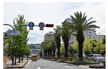
国道 26 号（フェニックス通り）
