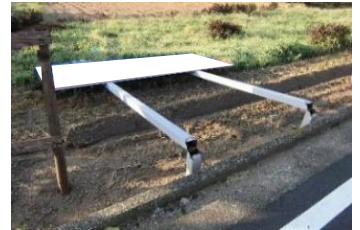
屋外広告物の倒壊
