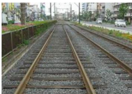
図表 更新した軌道 資料：堺市
