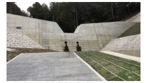
土砂災害対策施設の整備 (砂防堰堤) 出典：大阪府都市整備中期計画
