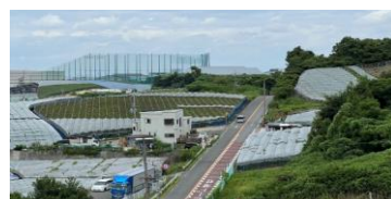
南河内グリーンロード 提供:大阪府
