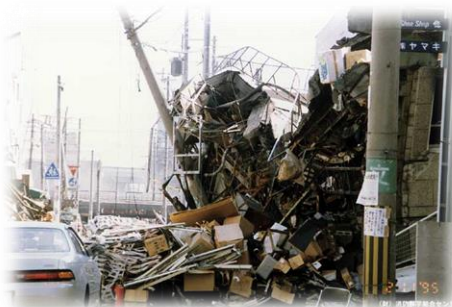
阪神・淡路大震災 建物被害と道路閉塞 出典：（一財）消防防災科学センター「災害写真データベース」
