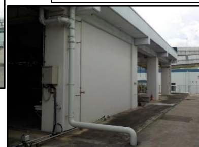
耐震化後（耐震壁設置）
