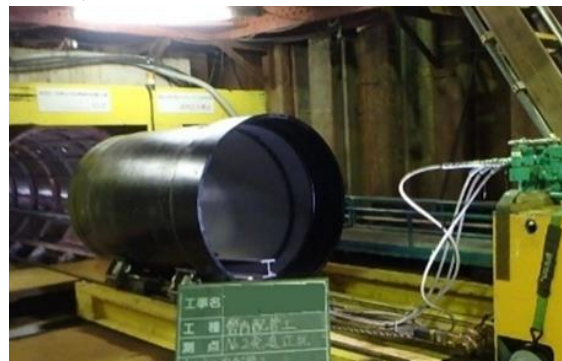
耐震管路φ1000mm 布設状況
