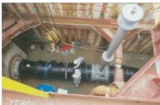
耐震管路φ900mm 布設状況
