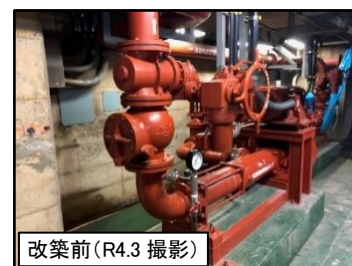
汚泥引抜ポンプ（泉北水再生センター）
