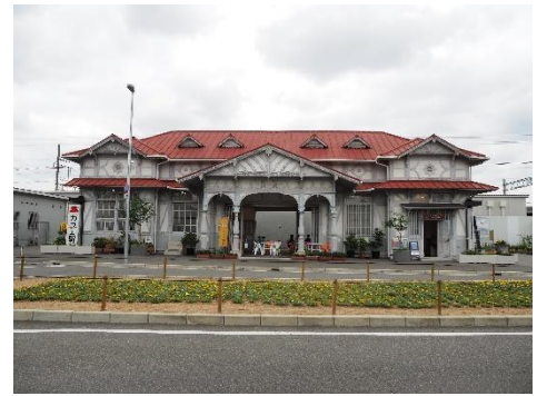
浜寺公園駅駅舎
